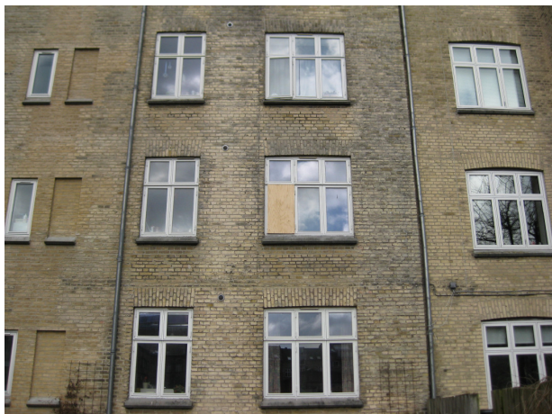
Ejendommens vinduer er ca. 20 gamle – dog er udskiftet enkelte partier. Kældervinduer er de oprindelige med 1-lags ruder.
