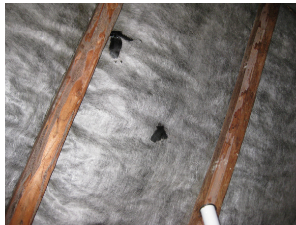
På spidsloft er oprindelig spærkonstruktion synlig og tilgængelig – behandling mod borebiller skal holdes under opsyn. Undertag er udført af banevare. God stand
