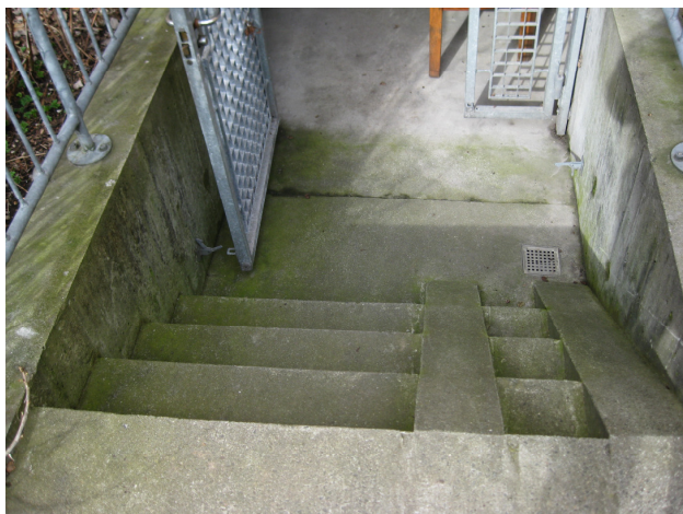
Kældertrappe mod gårdrum er i god stand – trænger til behandling og afrensning af algebegrøning
