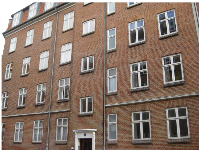
Gadefacade er opført i røde teglsten med trævinduer fra 1996. Murværk er repareret og omfuget i 1996. Murværk er generelt i god stand.
