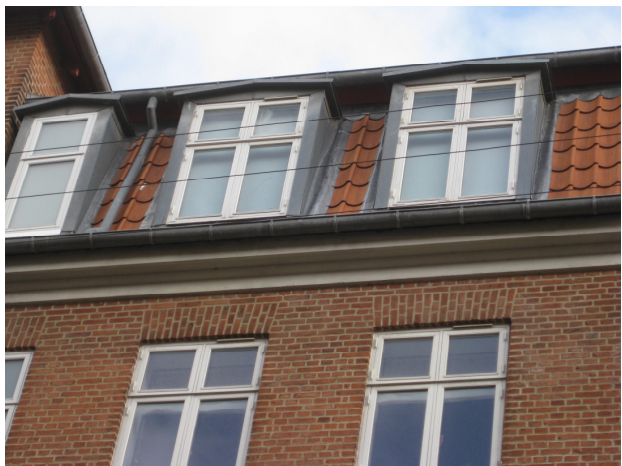
Tagbelægning af rød vingetegl, zinkbeklædte kviste, tagrender og nedløb i zink – fremtræder i god stand
