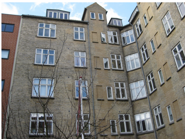
Gårdfacade er opført i gule teglsten med trævinduer fra 1996. Murværk er generelt i god stand
